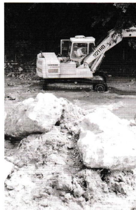
*Ausbaggern des Flussbettes und Errichtung einer steinernen Böschung.*
