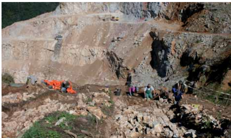
Grabungsarbeiten auf der Kanzelkuppe
